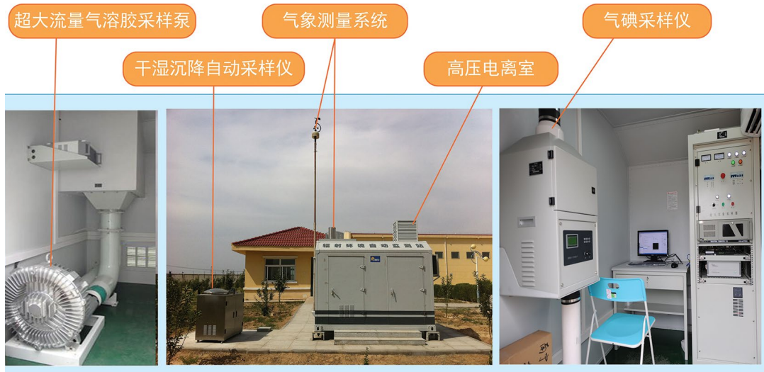
图3.2-2 辐射环境自动监测站配置图
